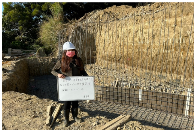
圖 7 擋土牆技師勘驗
