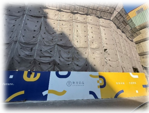
施工架設防塵網， 以減少塵埃的產生。
